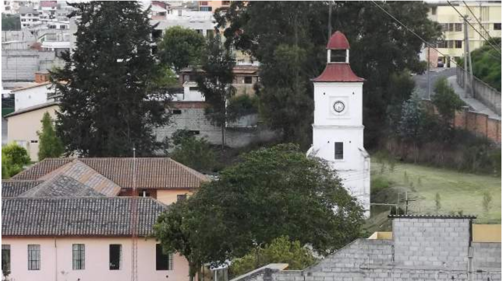
Foto N° 7. Instalaciones del Hospital Gonzálo González
