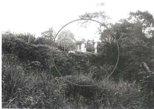
Campamento derrocado Hacienda Vilma Km 33-4 visto desde la vía Foto: Catalina Campo Imbaquingo Fecha: 28 de agosto de 2020
